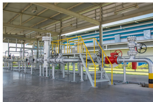
ระบบ Metering สถานีปรับปรุงคุณภาพก๊าซธรรมชาติ
